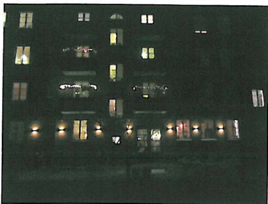
Huset fick fasadbelysning i början av 2012.
