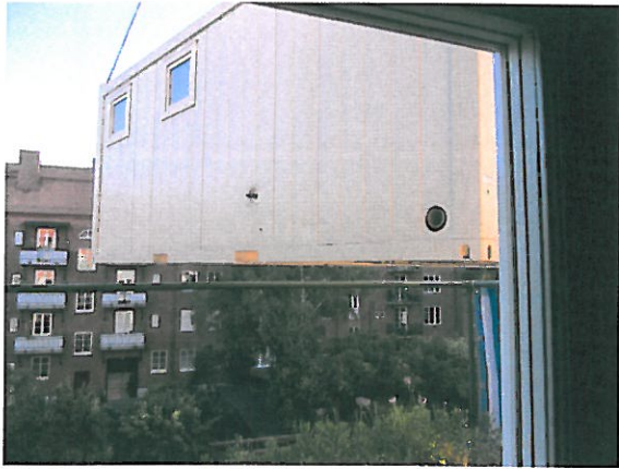
Toalett och duschbod lyfts in över huset till gården. .
