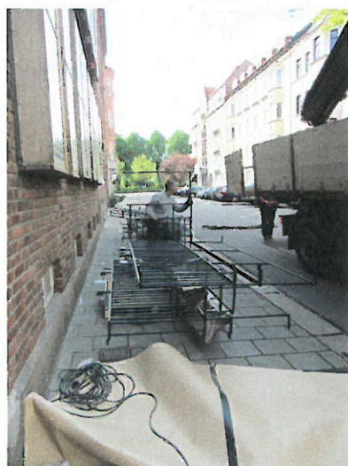
Provisoriska plastfönster. Balkongräcken på väg.
