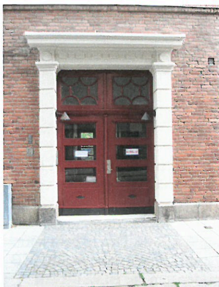
Nymålad port med nyrenoverad omfattning.
