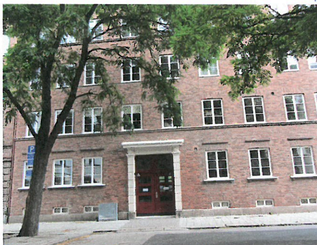
Fönstren mot gatan i nyrenoverat skick.
