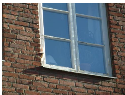
Fönstren är en annan underhållsåtgärd som krävt mycket arbete av styrelsen.
