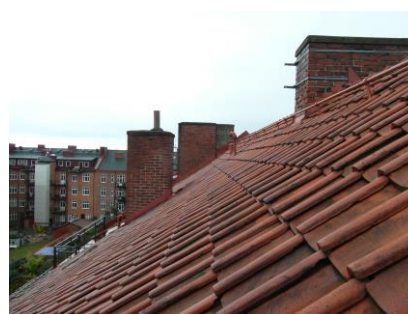
Taket fick muras om under taknockspannorna.
