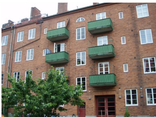
Under året har byte av balkonger behandlats.
