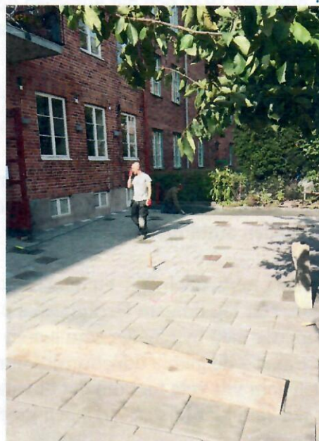
Gårdens samtliga hårdgjorda ytor byttes. Detta eftersom det var nödvändigt att ta bort asfalten på grund av dräneringen av grunden.
