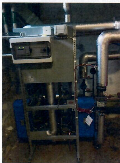
Ny fjärrvärmeväxlare på plats.
